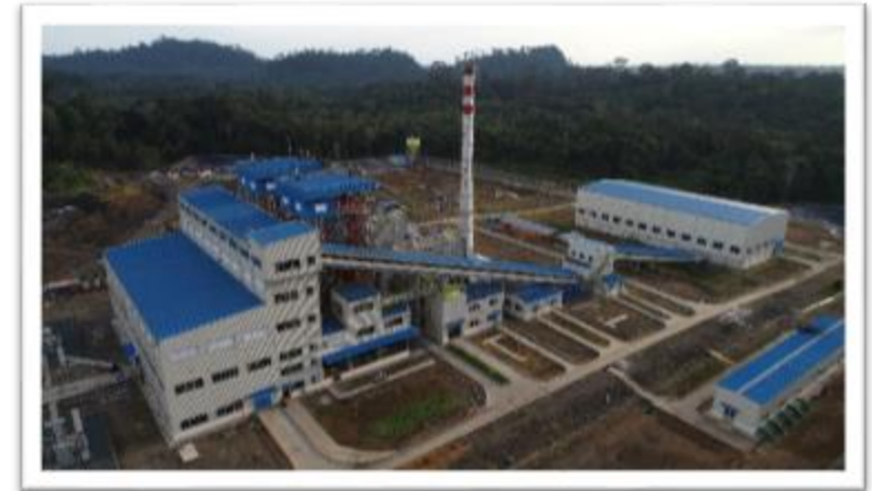
Foto: PLTU PAMA-1, September 2018
