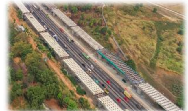
Foto: Proyek Jalan Tol Layang Jakarta-Cikampek II
